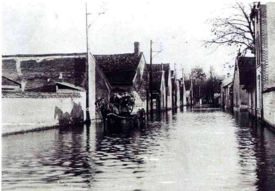
Inondations de 1924 à Jâlons
